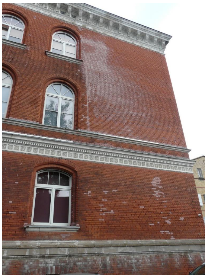
Elewacja boczna. Cegły zabrudzone zanieczyszczeniami beżowej pobiałki wapiennej.
