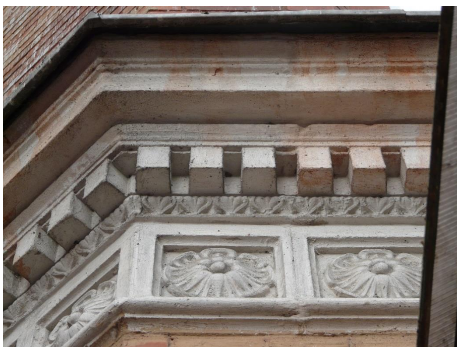
Detale sztukatorskie z ubytkami na stykach i krawędziach, przemalowywane.
