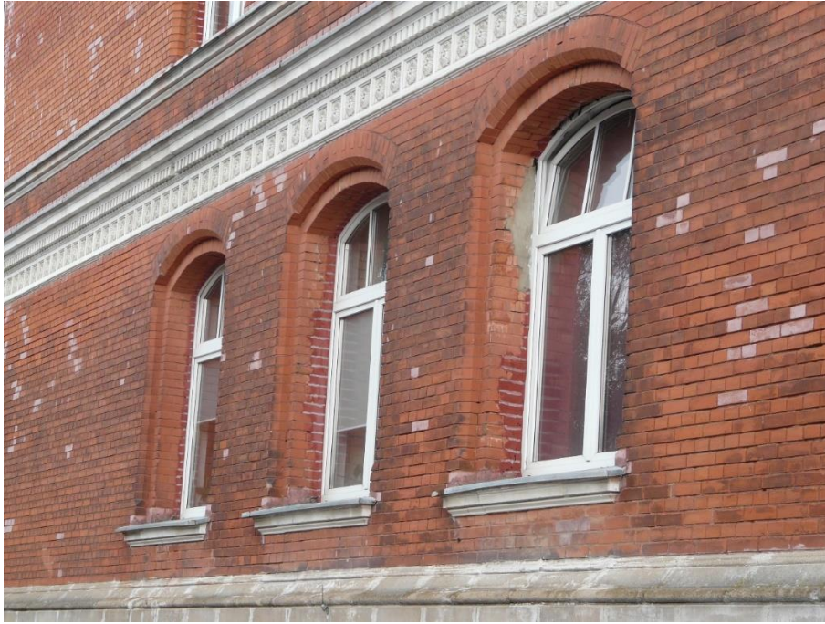
Elewacja boczna. Wygięte parapety, część cegieł przemalowana, uzupełnienia
