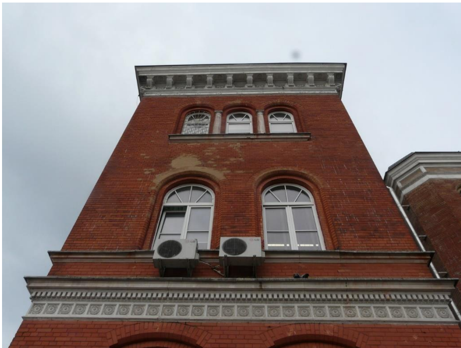
Elewacja tylna. Nad oknami łaty beżowej pobiałły. Blacharki wypaczone. Kolumnienki z wypłukany licem.
