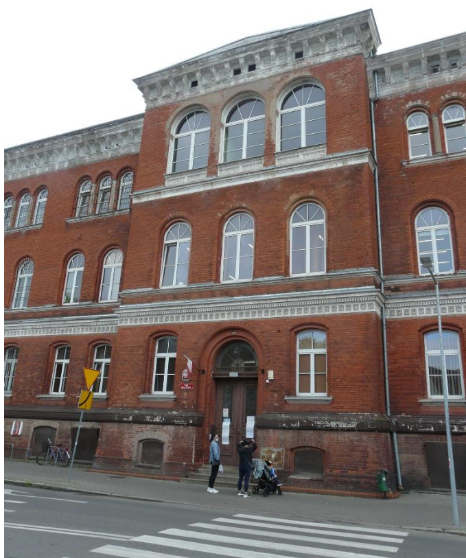
Fasada. Część elewacji ceglanej pod naczółkiem zrekonstruowana z zaprawy cementowej. Wypaczone blacharki gzymsów.
