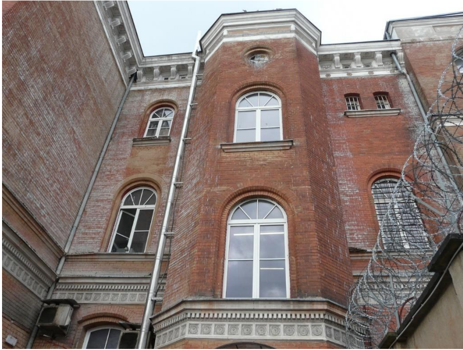
Elewacja tylna. Powierzchnia pokryta nalotem ptasich odchodów i miejscowo warstwą beżowej pobiałły.
