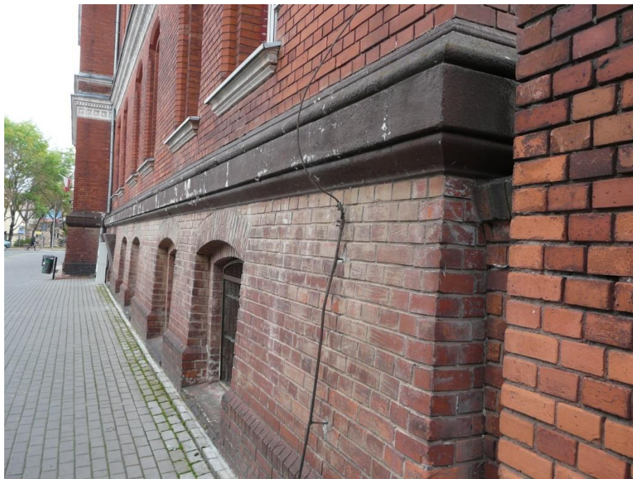
Fasada. Przemalowany gzyms i cegła cokół. Ubytki w warstwie malarskiej, zabrudzenie powierzchni.
