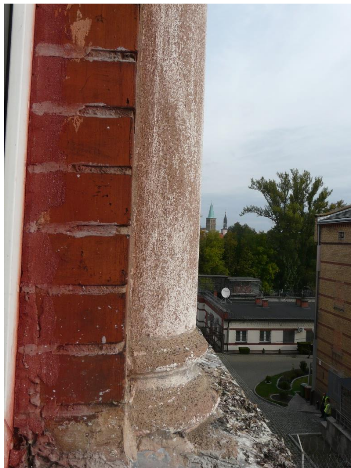
Wytlukana powierzchnia kolumnienki, opierzenie blacharskie zabrudzone odchodami ptasimi. Obramienie okna uzupełnione zaprawą z namalowanym wzorem cegieł.
