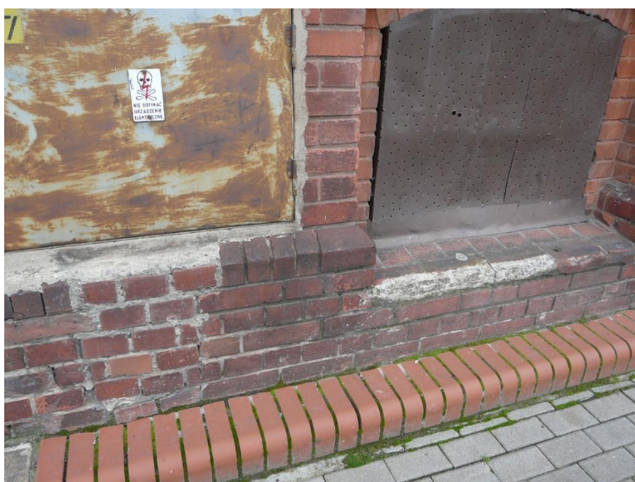
Wtórne uzupełnienia z zaprawy cementowej, ubytki w spoinie, korozja metalu.
