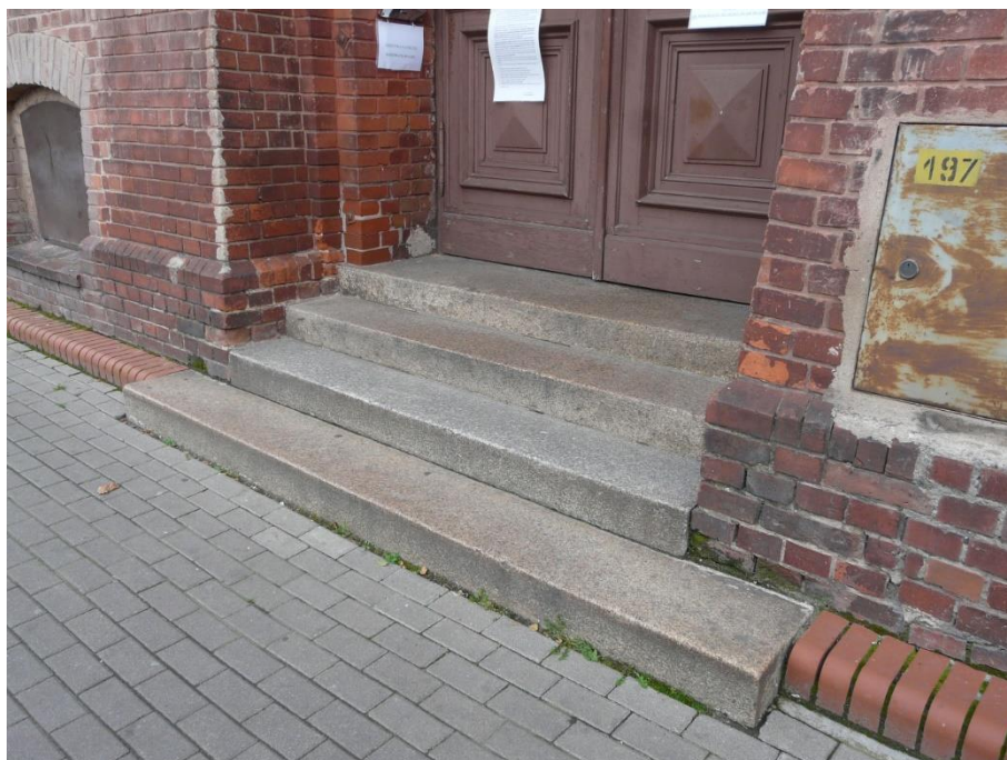
Schody o zabrudzonej powierzchni, liczne ubytki w spoinie, uzupełnienia z zaprawy cementowej.
