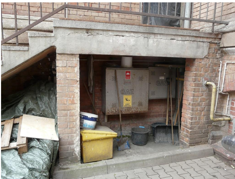
Schody betonowe ze spękaniem płyty.
