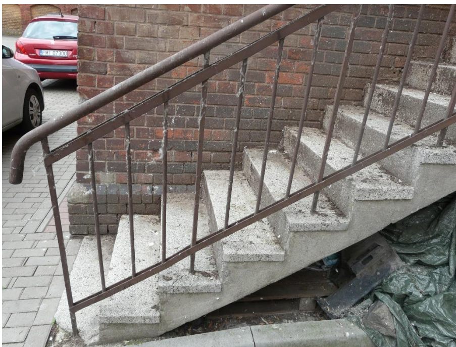
Elewacja tylna. Betonowe schody pokryte ptasimi odchodami, z ubytkami na krawędziach.
