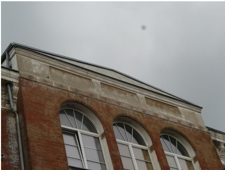
Elewacja tylna. Zwieńczenie części środkowej. Resztki beżowobrazowej farby w płycinach, beżowe zacieki na cegle, ubytki w rozetkach fryzu.
