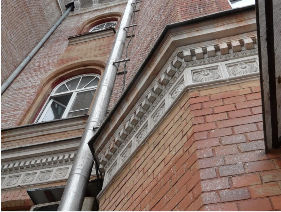
Elewacja tylna. Zacieki z pobiały pod detalami architektonicznymi.
