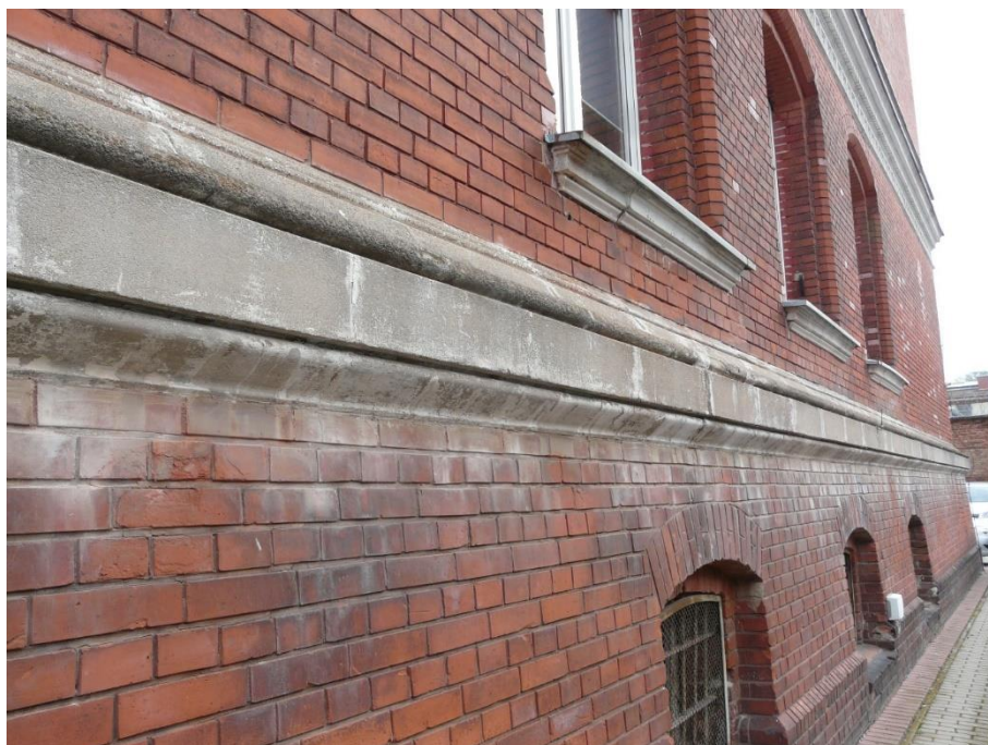
Elewacja boczna. Cokół zabrudzony wypłukaną farbą.
