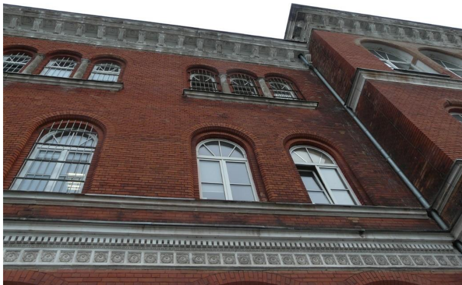
Fasada. Zabrudzenia przy gzymsach i narożnikach.
