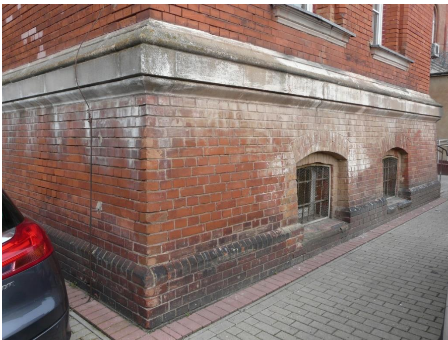
Elewacja tylna. Cokół z zabieleniami, fałszywą patyną w dolnej części, wypaczona blacharka parapetu.
