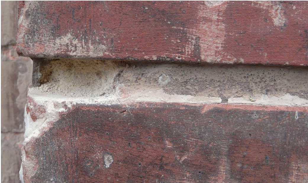
Fot. Wapienna zaprawa murarska z warstwą brązowej spoiny
