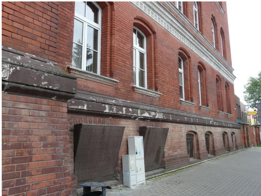
Cokół od frontu. Przemalowany gzyms i cegła cokół. Ubytki w warstwie malarskiej, zabrudzenie powierzchni, łuszcząca się cegła.
